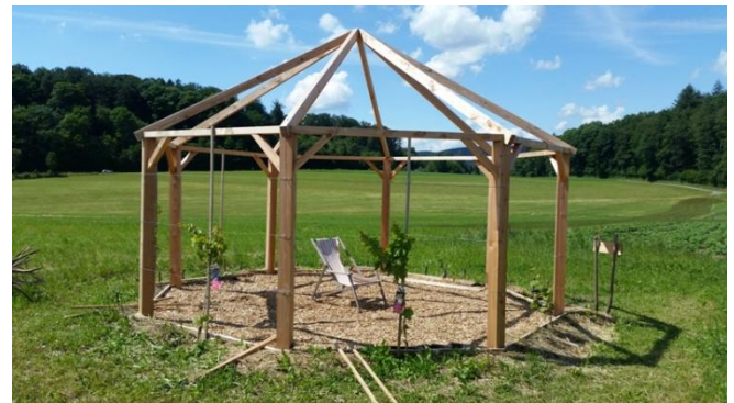
Bild: Solawie, Ansicht des Rankgerüsts
